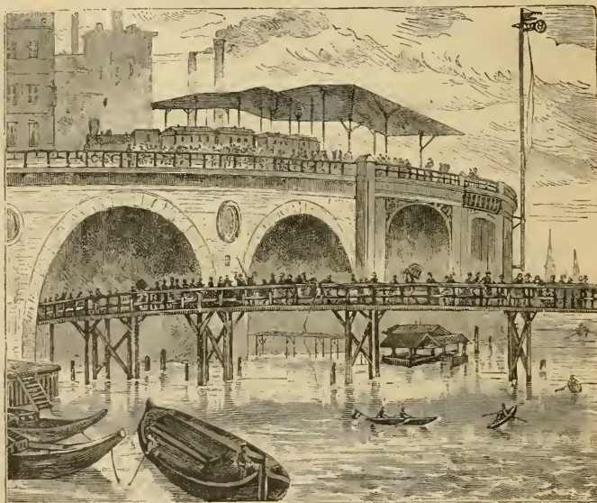
Fig. 178. — STATION DU PONT DE JANNOWITZ SUR LA SPRÉE
